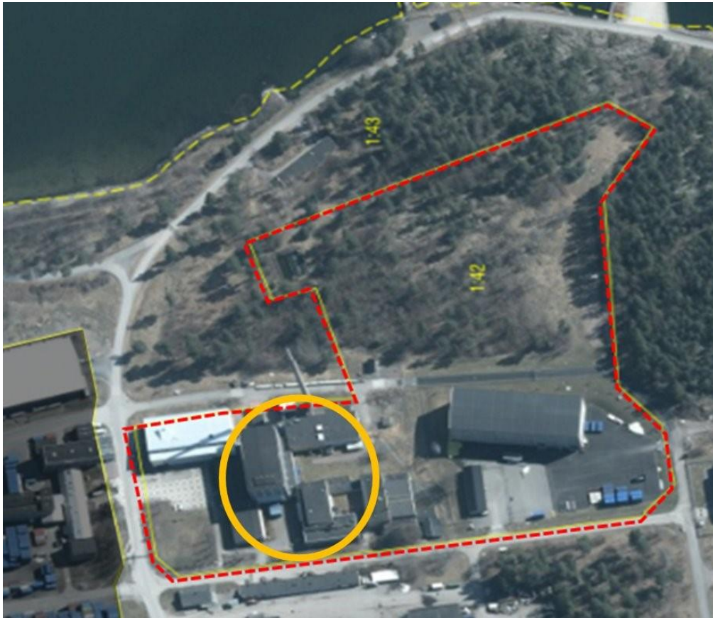
Figur 3. Tidigare byggnader inom gul ring håller på att rivas och möjliggör därmed plats för ny hanteringsanläggning.
